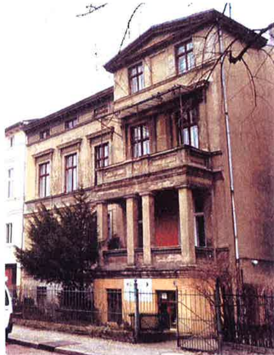
Typische Kragdachkonstruktion über Balkon
