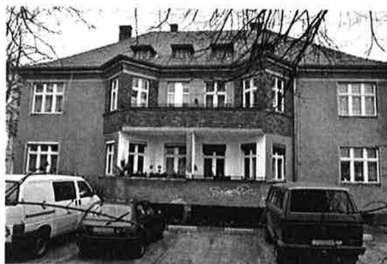
Siedlungsbau der 20er Jahre, Hans-Sachs-Straße mit Walmdach
