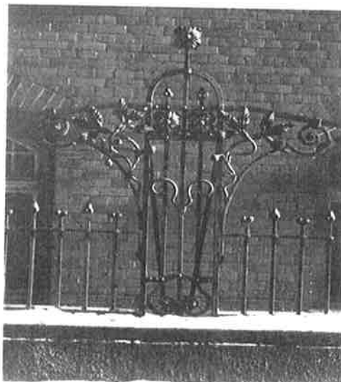
Einfriedung mit floralen Schmuckelementen, Gliederung in drei Zonen (Sockelzone, mittlere Zone, Abschlusszone)
