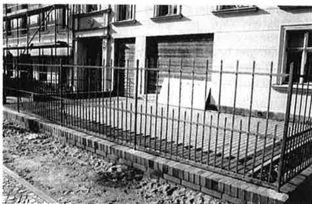
Negativbeispiel: vollflächige Versiegelung des Vorgartens
