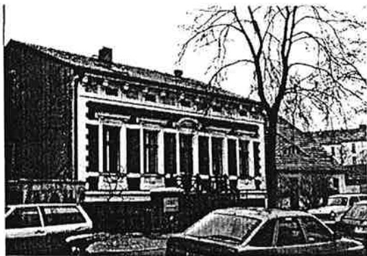
Trauftyp, eingeschossig mit Souterrain-, und Mezzaningeschoss
