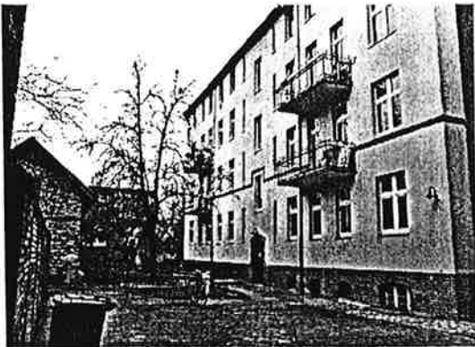
Wohnnutzhof mit tradierten Gestaltelementen und Oberflächenbelägen
