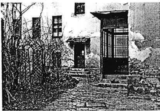
Garten- und Schmuckhof mit noch ursprünglich vorhandenen Grün- und Zierelementen
